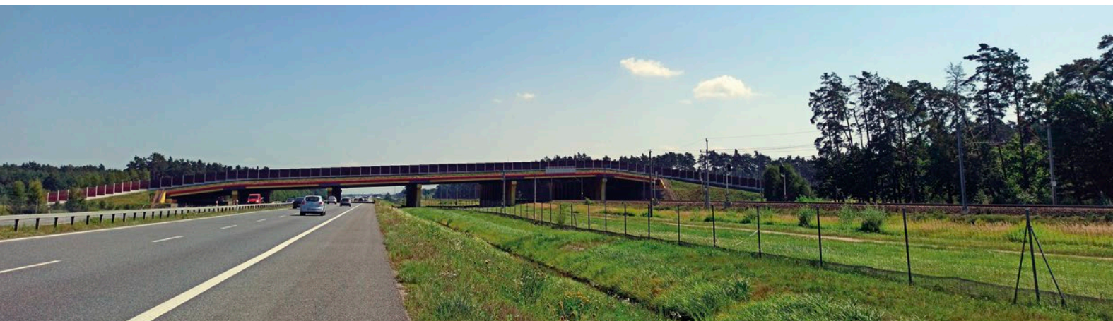
Fot. 19. Przejście dla zwierząt na autostradzie A4 (DK)
